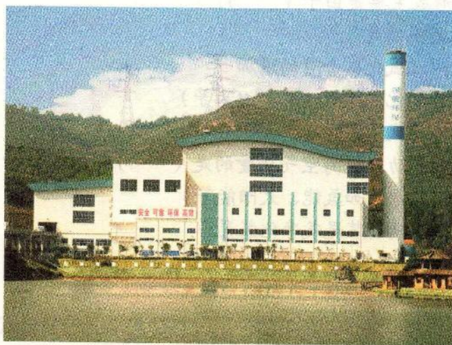
图9-20 垃圾沼气发电厂
