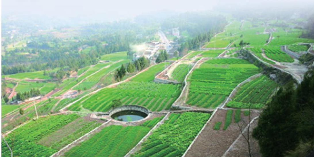
图 7-2-14 四川省仪陇县复兴河小流域“坡改梯”工程
