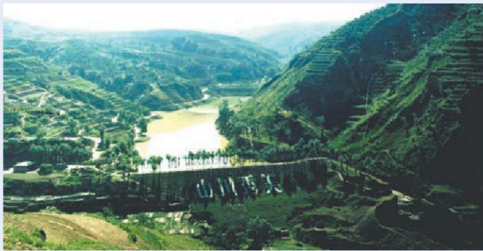
图 7-1-12 陕西省绥德县韭园沟流域骨干坝
