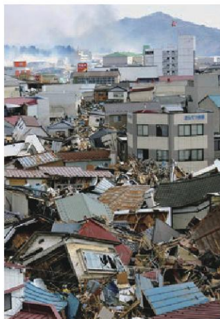
图 8-2-6 地震中倒塌的建筑物
